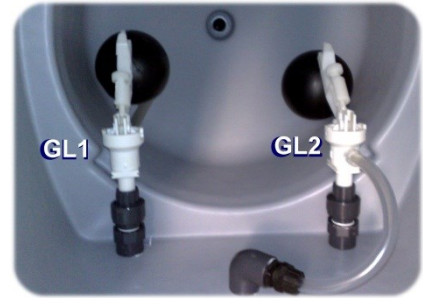
Regelschraube GL2 (Füllstandskontrolle Chlorierung)
